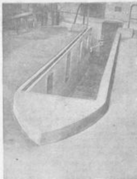
Рис. 3. Граншейная тушиковая канава. Граншея обеспечивает безопасность входа и выхода персонала из канавы и облегчает контроль за осмотрами работами
